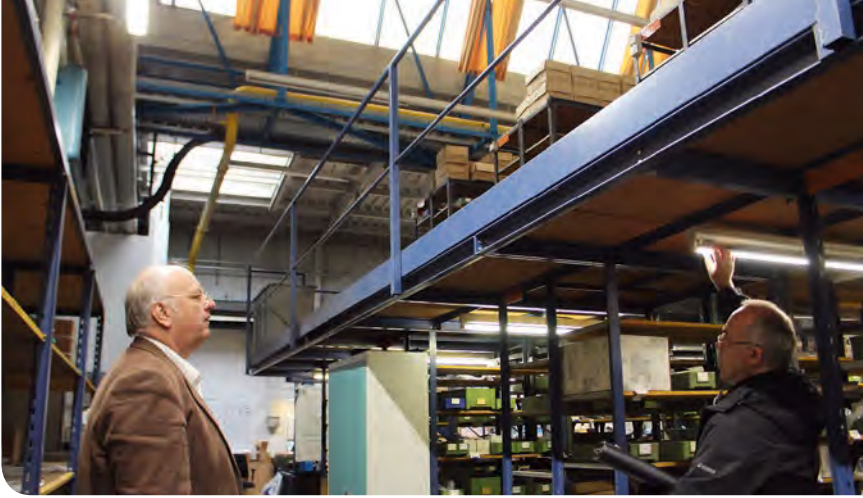
Energieeffiziente Lichtbänder statt Sheddach könnten Energie sparen. Foto: Edelmann
