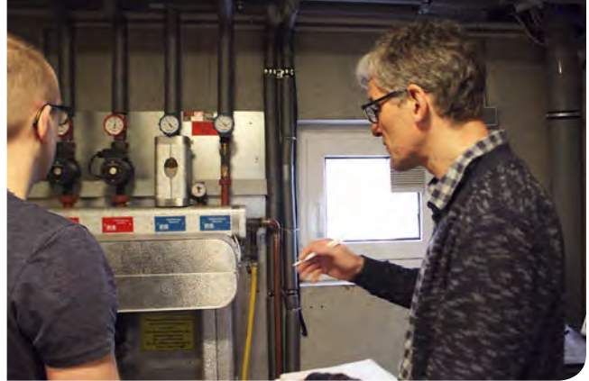
KliBA-Berater Jung kontrolliert Fensterdichtung und Fernwärme-Übergabestation. Foto: Edelmann
