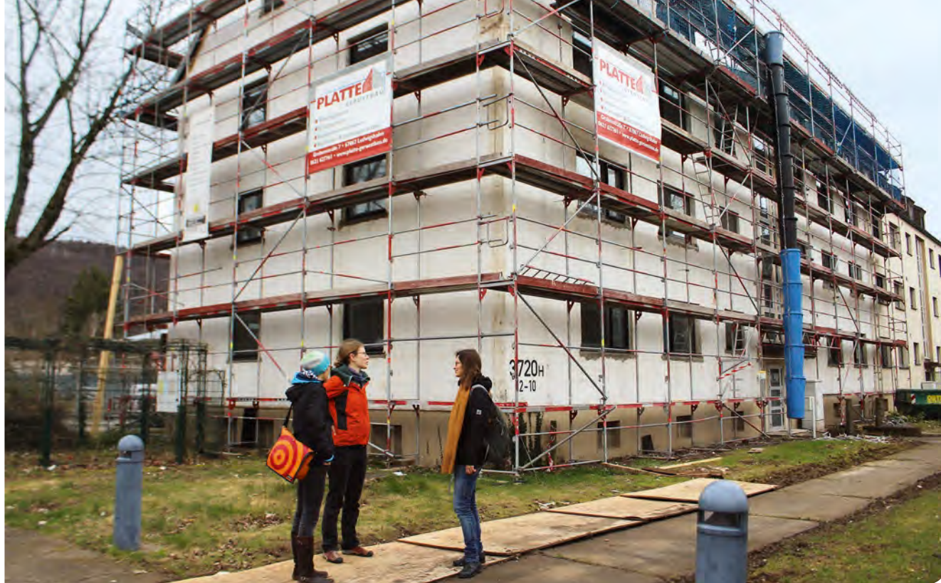
Drei Konvisionärinnen inspizieren wöchentlich den Baufortschritt an den Barracks. Foto: Edelmann
