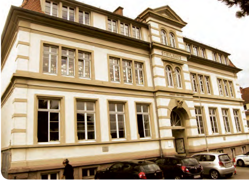
Neuenbergschule: Aktuell werden fernauslesbare Verbrauchszähler installiert. Foto: KliBA
